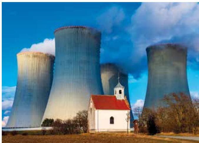
Jaderná elektrárna Dukovany
